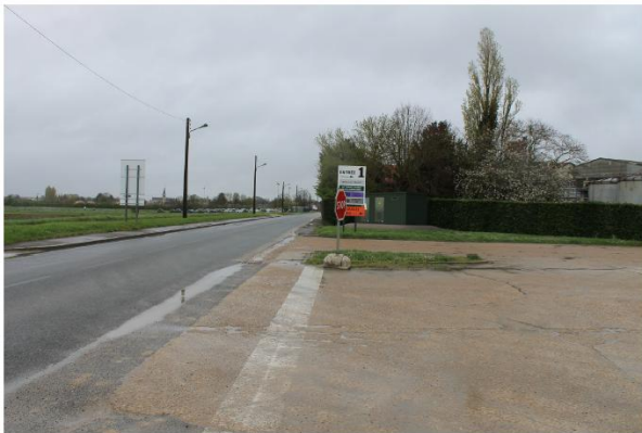
Vue du poste de livraison, en bordure du site principal de la Sucrerie, depuis la RD31
