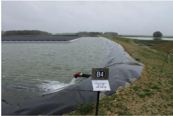
Vue de la centrale solaire depuis le Nord du bassin 4 au sein du site principal de la Sucrerie
