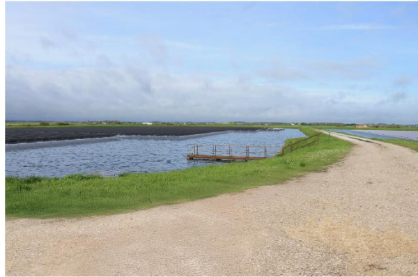
Vue de la centrale solaire depuis l'entrée du site de Pampou
