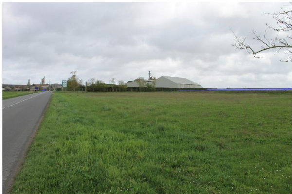
Vue en transparence de la centrale solaire depuis les habitations en bordure Ouest du site principal sur la commune de Lorcy
