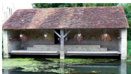
La restauration du lavoir de Sceaux du Gâtinais (2003/2004)
